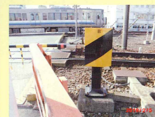
和歌山駅南側の踏切しゃ断器
