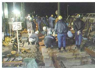
分岐器交換夜間作業
