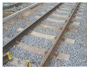
コンクリート枕木に交換
